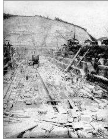
▲② 建造中の浦賀ドックの1号船渠
