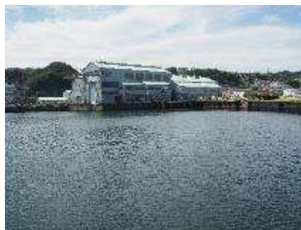
▲ 解体される浦賀ドックの機関工場 遠方に大きく映る建物が機関工場。 令和元年度内に解体。
